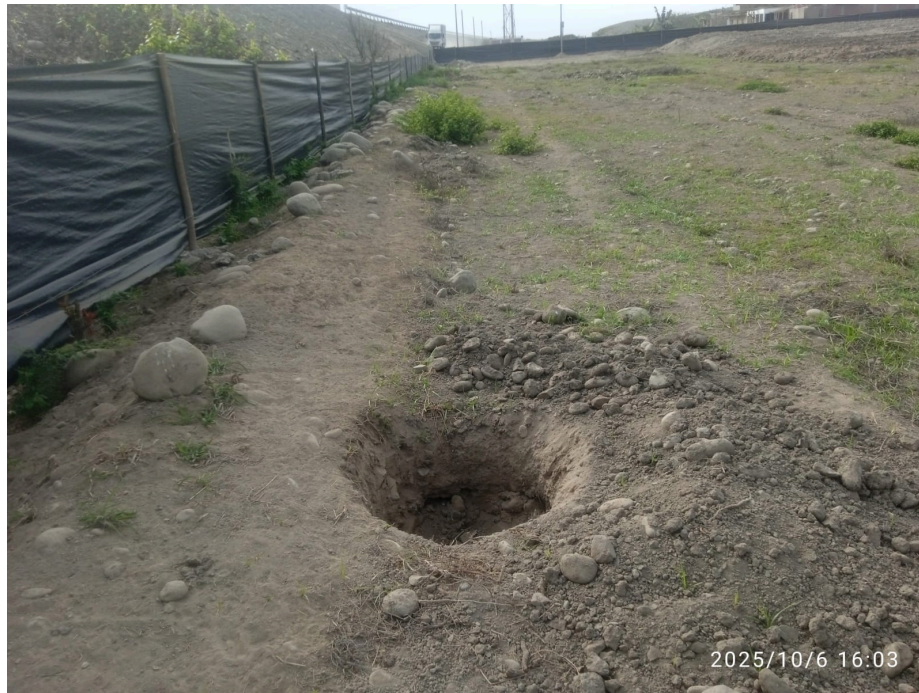
Imagen 2: Excavaciones para Postes de Luz
